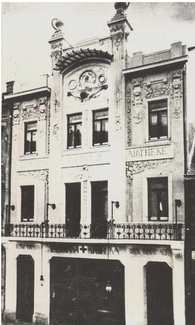
14. Ulično pročelje zgrade Pečić nakon izgradnje (preslika fotografije u fototeci Konzervatorskog odjela u Zagrebu, inv.br.1041)
