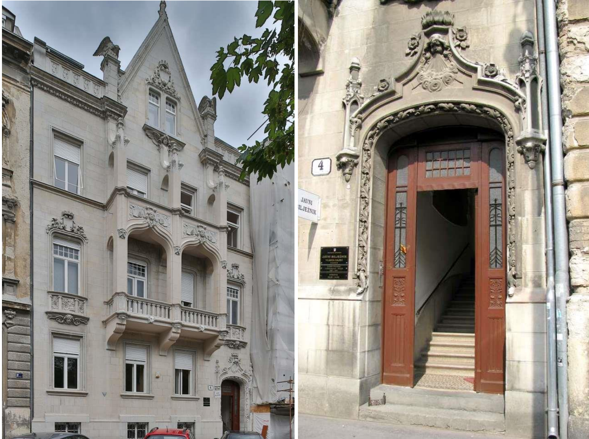
53. i 54. Zgrada Feller (Zagreb, Trg kralja Tomislava 4), ulično pročelje (foto: Z.Bogdanović, 2015.); detalj pročelja: ulaz (foto: M. Strugar, 2011.)
