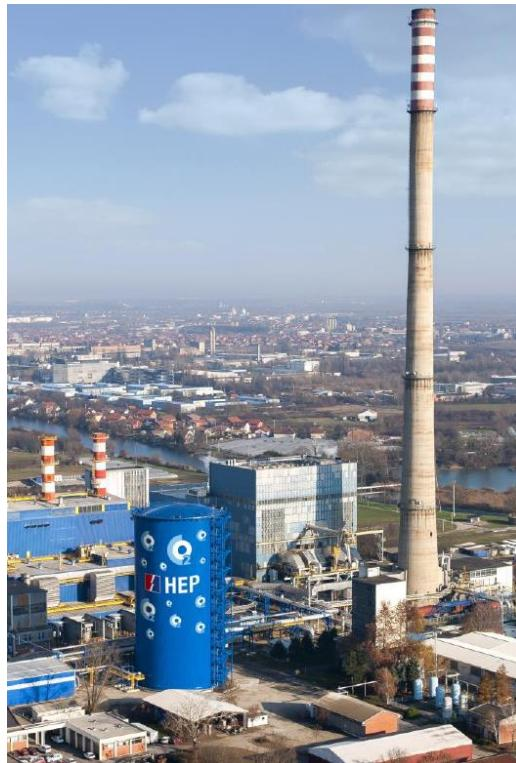
**Slika 3.34.** Akumulacijski stratifikacijski spremnik osjetne topline TE-TO Zagreb
