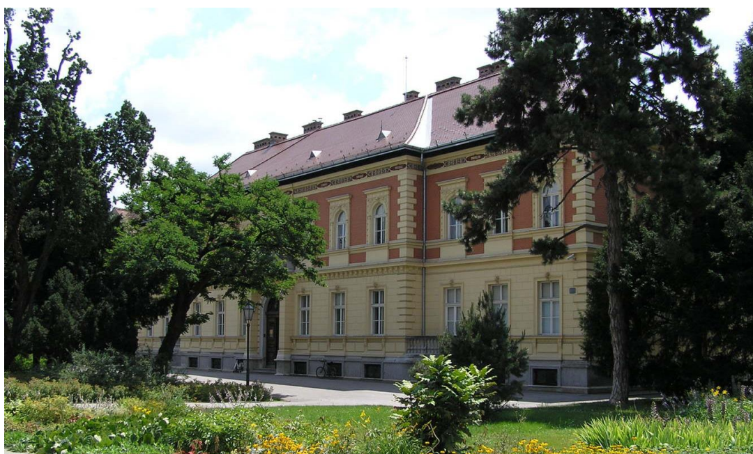
Slika 35. Nekadašnja zgrada Sveučilišnog lučbenog zavoda koja je izgrađena 1884. godine prema zamisli Gustava Janečeka, a kasnije preimenovana u Kemijski Institut. Danas se u toj zgradi nalazi knjižnica Hrvatske akademije znanosti i umjetnosti
