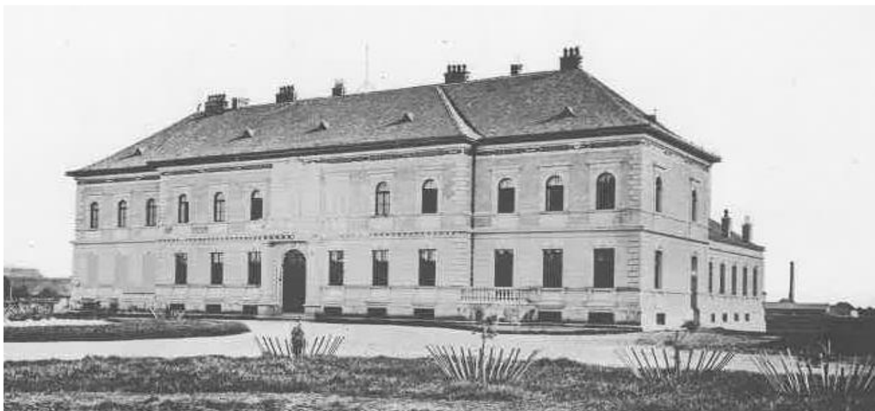
Slika 32. Pročelje zgrade Sveučilišnog lučbenog zavoda izgrađene 1884. godine (Janeček, 1885.)
