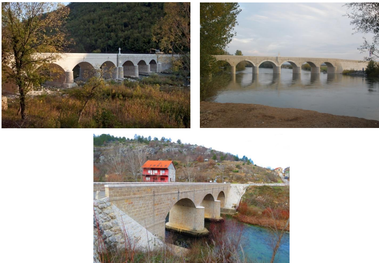
Fotografija 4.4. Povijesni cestovni mostovi na području SDŽ-a; odozgo prema dolje, po redovima: Pavića most (Podgrađe) (Radnić i Smilović, 2008), Most na Panju (Rumin), Balečki most (Vinalić)
