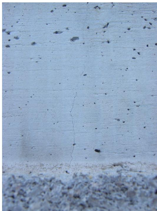
Fotografija 6.12. Prikaz vertikalne pukotine po dužini ploče
