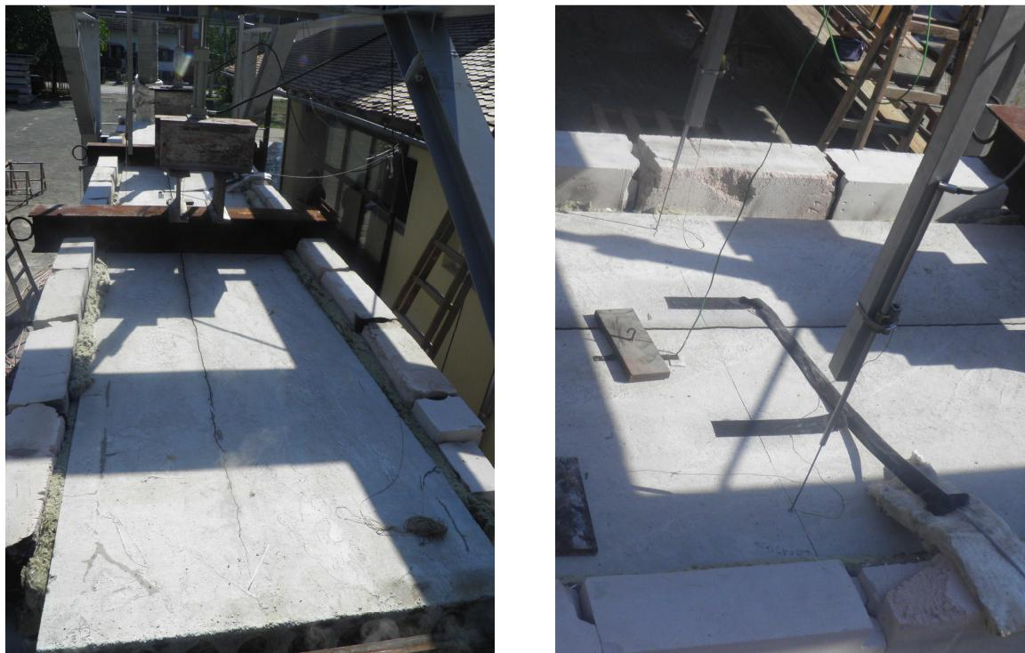
Fotografija 6.10. Prikaz uzdužne pukotine na ploči
