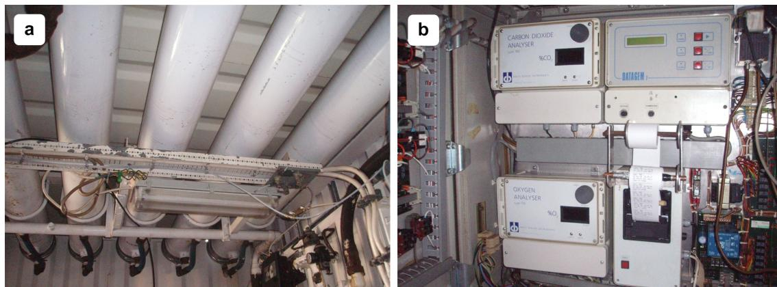
**SI. 2.18. Generator dušika ili CA uređaj u palubnom kontejneru: membranski separatori (a) i analizatori ugljičnoga dioksida i kisika (b)**
