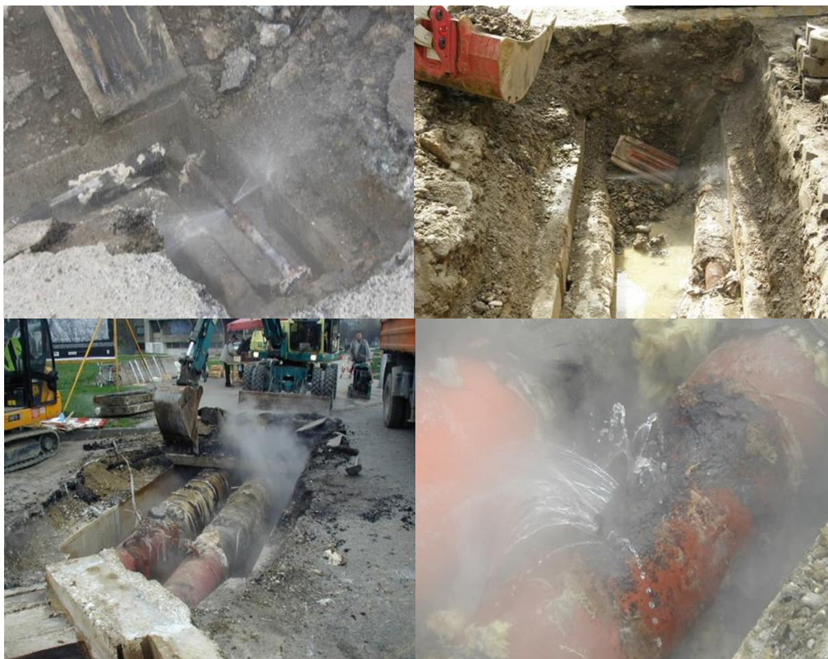
Slika 7.13. Propuštanja cjevovoda
