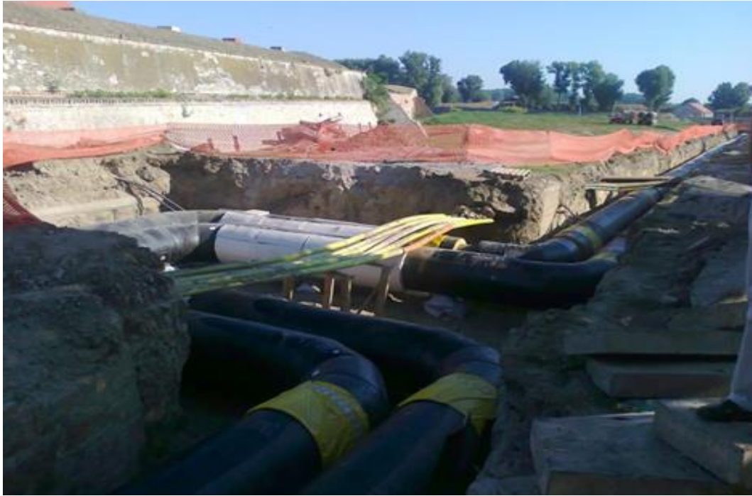
Slika 7.3. Revitalizacija vrelovodne mreže u Osijeku
