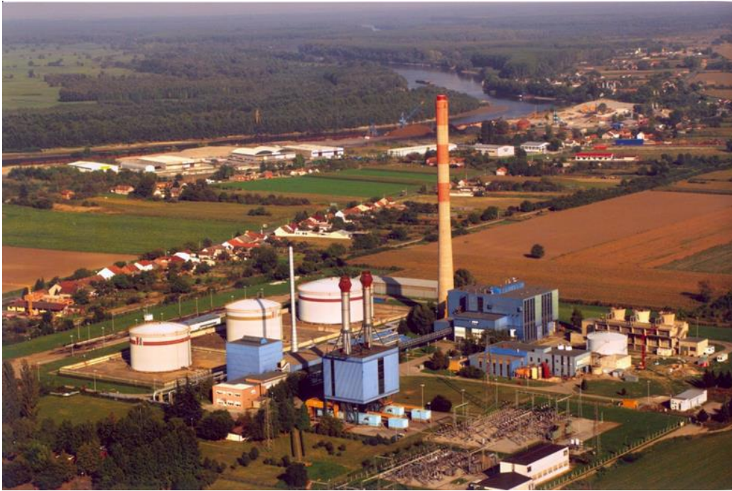
Slika 10.2. Termoelektrana - toplana Osijek
