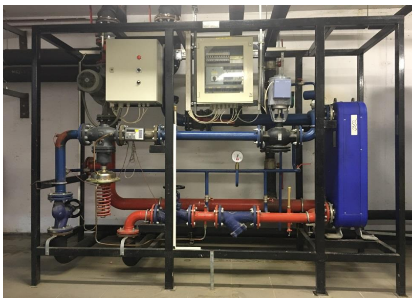
Slika 10.5. Toplinska podstanica indirektnog tipa (Kompakt)
