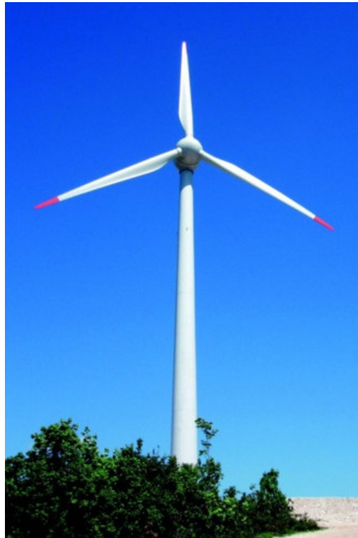
Slika 80. Končar vjetroagregat K80, nazivne snage 2,5 MW
