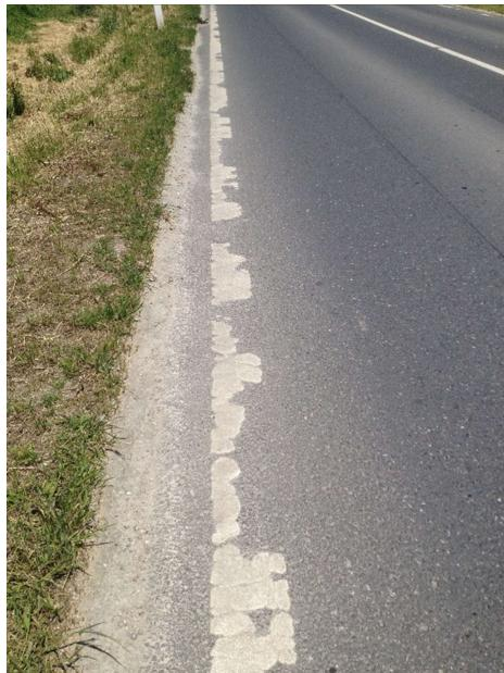
Slika 31. Prikaz oštećene i istrošene termoplastike
