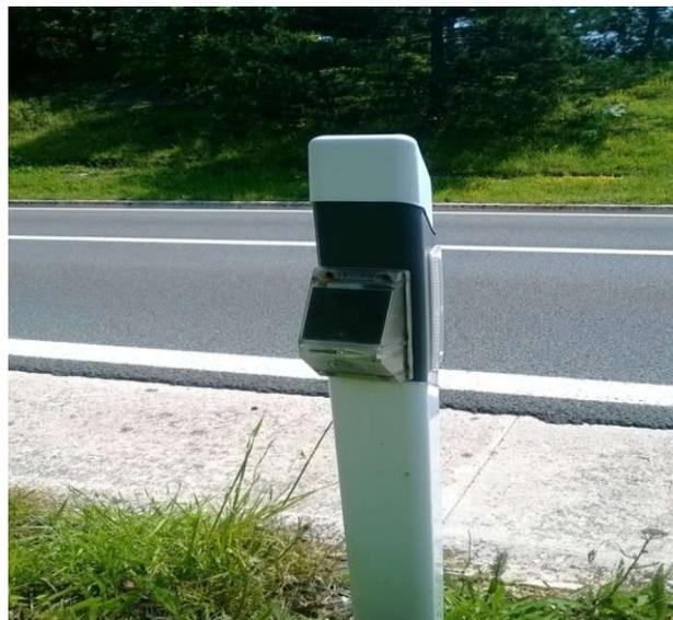
Slika 41. Zvučni senzor na smjerokaznom stupiću
