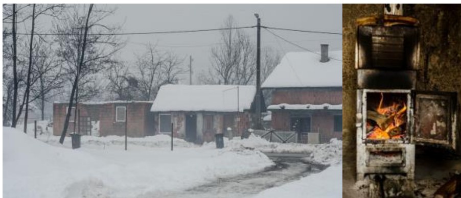
Slika 5-14 Primjer neučinkovitih zgrada i sustava grijanja u SMŽ 25
