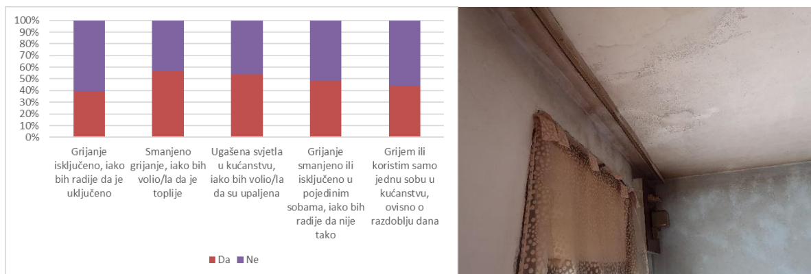
Slika 5-49 Postotak kućanstava koja primjenjuju „prisilne“ mjere štednje energije (lijevo) i primjer plijesni (desno) za slučaj Zagreb
