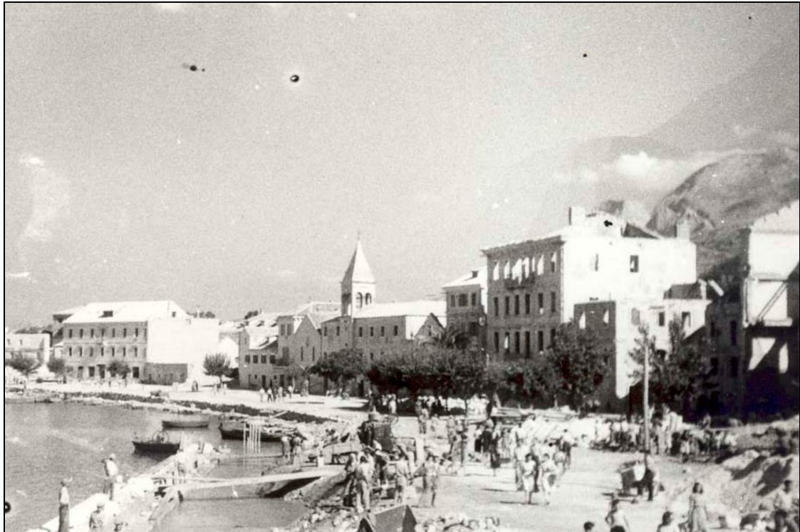
Slika 32. Obnova makarske luke 445
