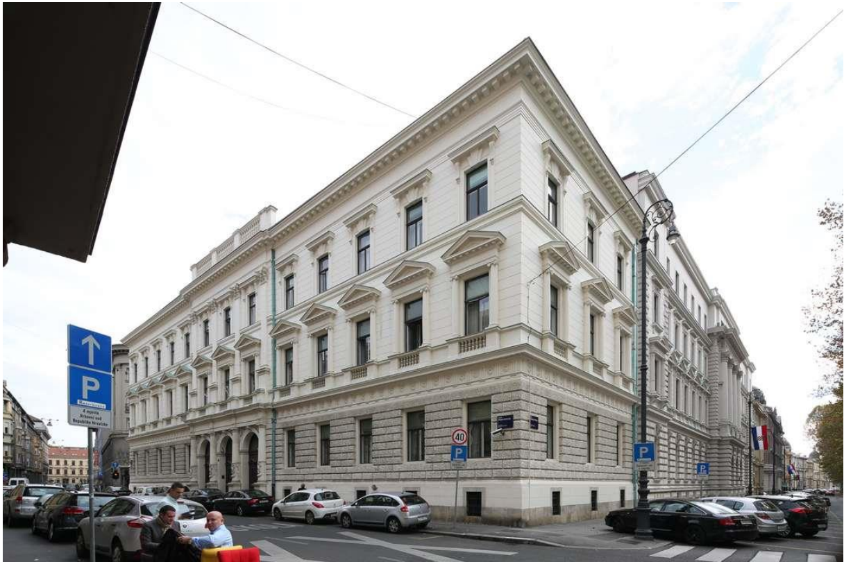
167. Zgrada Kraljevskog kotarskog suda (Zagreb, Petrinjska 8/Amruševa 2), ulično pročelje u Amruševoj ulici (desno) i Petrinjskoj ulici (lijevo), (foto: Z. Bogdanović, 2015.)
