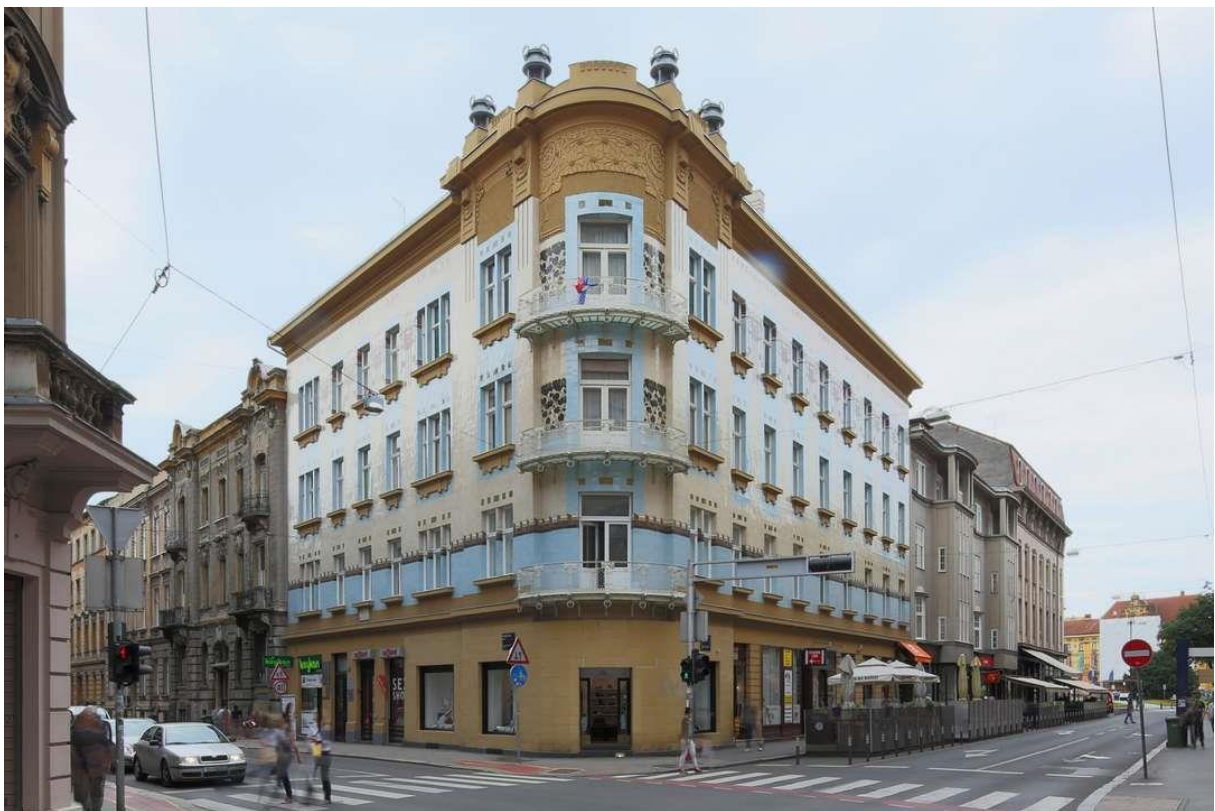
264. Zgrada Kallina (Zagreb, Gunduličeva 20/Masarykova), ulično pročelje (foto: Z. Bogdanović, 2015.)
