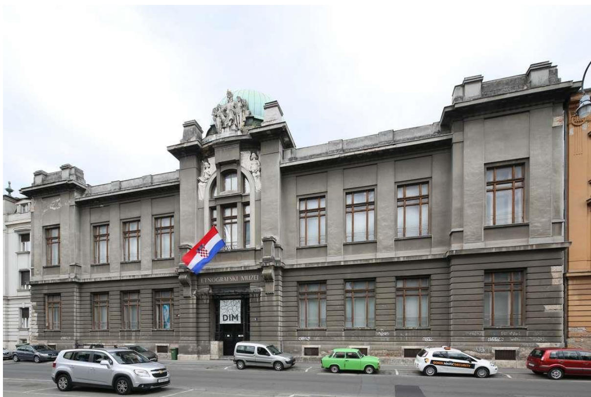
234. Trgovačko-obrtni muzej (Zagreb, Trg Mažuranića 14), ulično pročelje (foto: Z. Bogdanović, 2015.)
