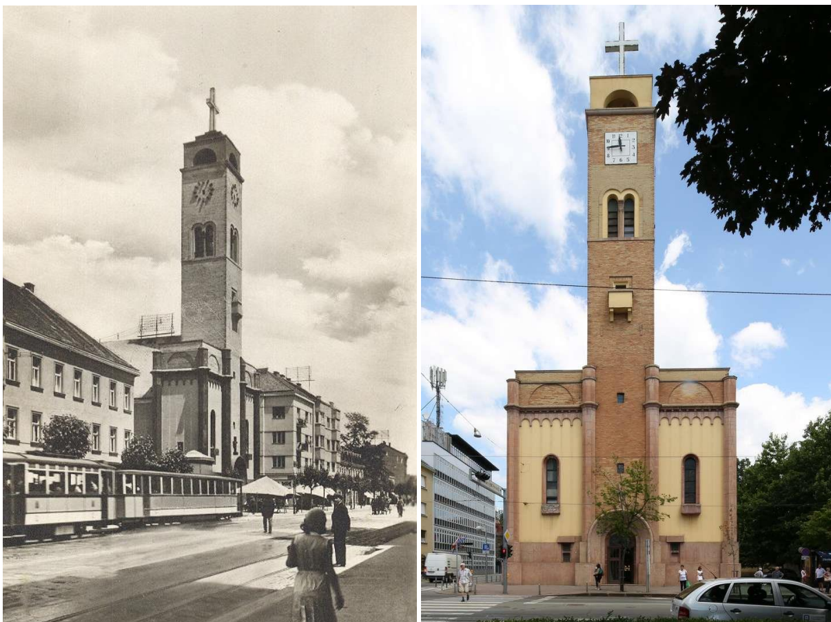
120. i 121. Župna crkva sv. Petra (Zagreb, Vlaška 93), izgled nakon rekonstrukcije 1930.-1932. godine (Konzervatorski odjel u Zagrebu, razglednica bez datacije i nakladnika); Glavno južno pročelje crkve, današnje stanje (foto: Z. Bogdanović, 2015.)
