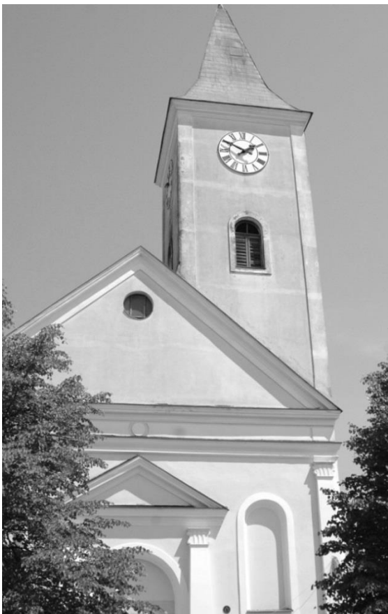
Slika 27: Margečan, Župna crkva sv. Margarete, pročelje, Foto: I. Potočnik, 2013.
