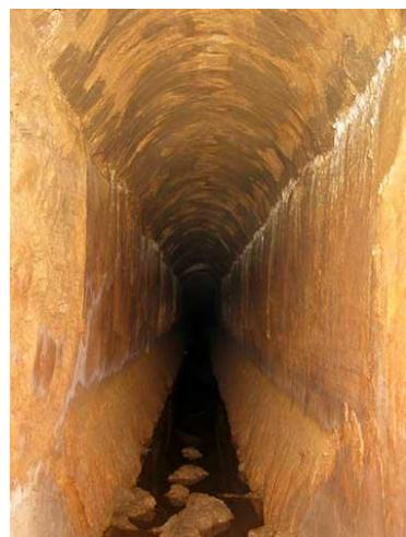
Slika 3.1.3. Tunel akvadukta. (preuzeto iz: KONZERVATORSKI ELABORAT zaštite i obnove Dioklecijanovog akvedukta na lokaciji Brodarica-istok)
