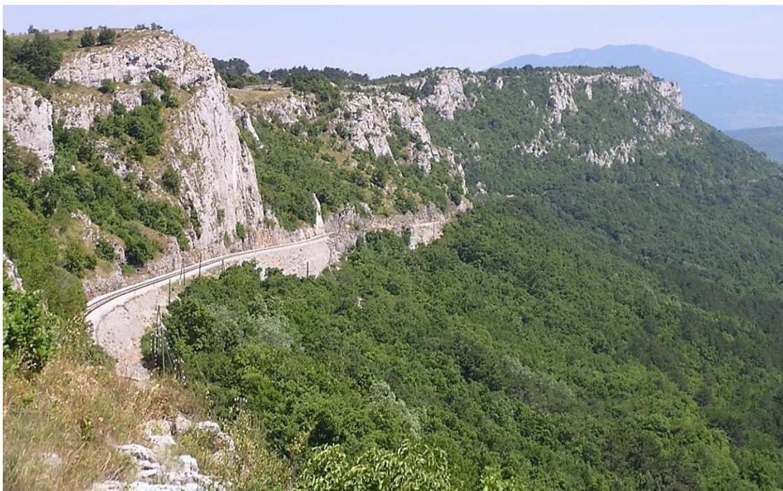
Slika 2.2. Panoramska slika dijela Ćićarije s čeonim dijelovima ljusaka izgrađenih od paleogenskih foraminiferskih vapnenaca. Zasjek željezničke pruge Lupoglav–Buzet–Divača. Pogled sa sjeverozapada prema jugoistoku (u pozadini je Učka), tektonski transport je prema jugozapadu (udesno).
