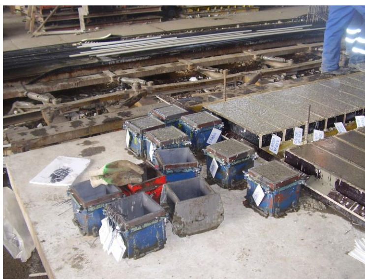
Slika 3.3 Betoniranje kalupa za ispitivanje tlačne čvrstoće betona i vlačne čvrstoće betona cijepanjem
