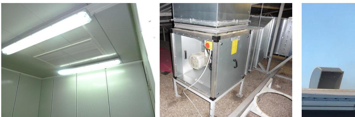
Slika 2.3. Sustav ventilacije ispitne kabine, lijevo – kabina, sredina – pogon, desno – ispuh
