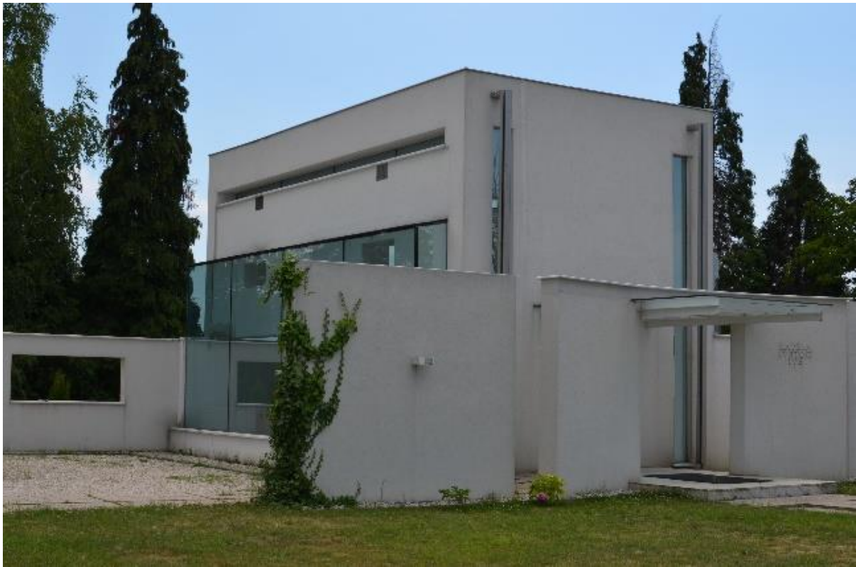
Kat. I. Sl. 36. Odnos staklenih stjenki i betonskih zidova na kapelici sv. Ive na Plehanu, (2016.).
