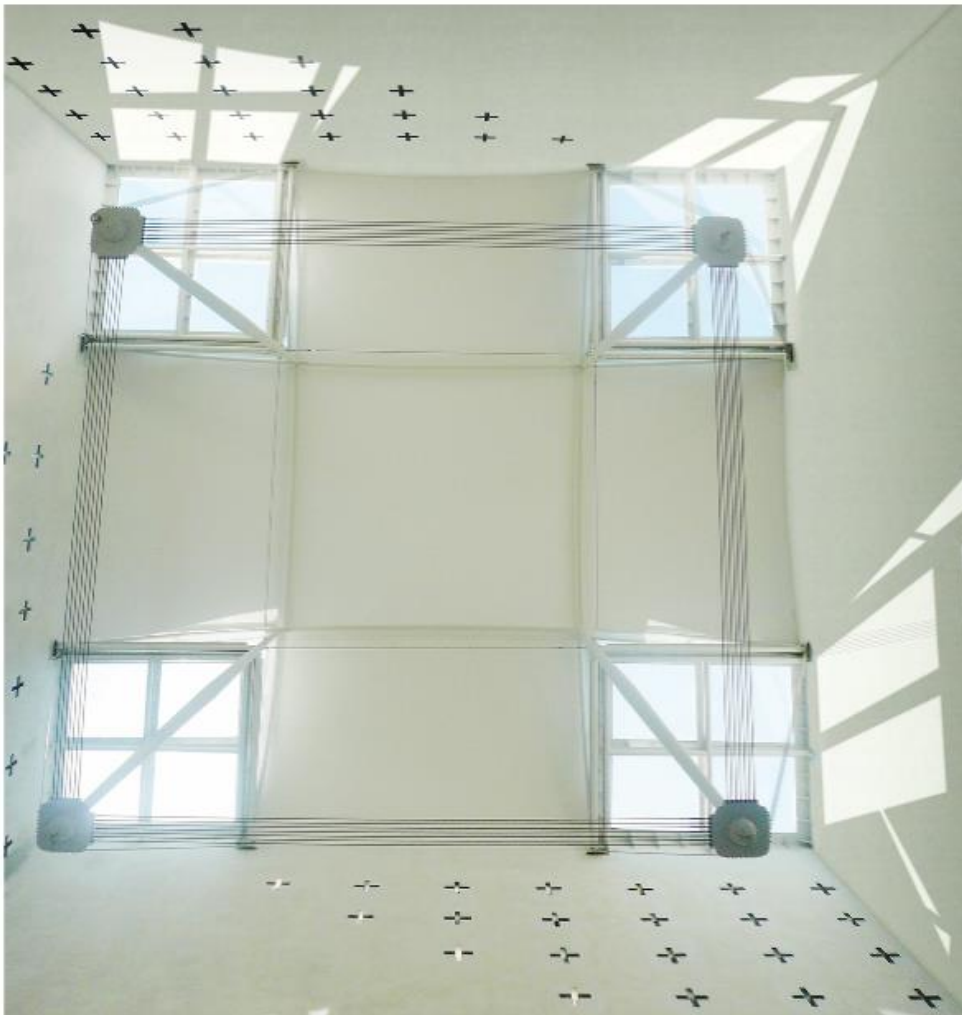
Kat. I. Sl. 35. Stropna konstrukcija u crkvi sv. Marka na Plehanu. (s. a.).
